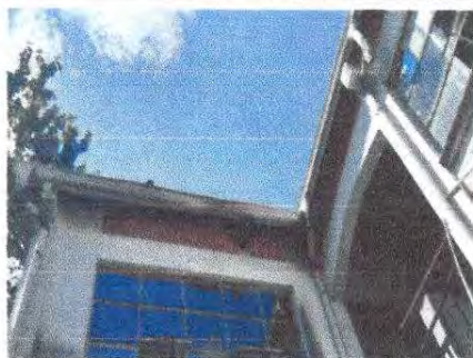
Foto 3: SUSTITUCION DE CANAL DE PVC
