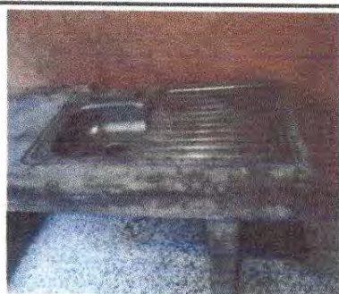
Foto 17: SUSTITUCION DE LAVASTOS (INCLUYE MEZCLARORA )
