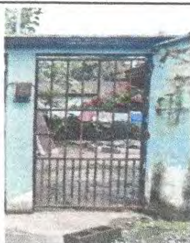
Foto 9: MANTENIMIENTO DE PORTON
