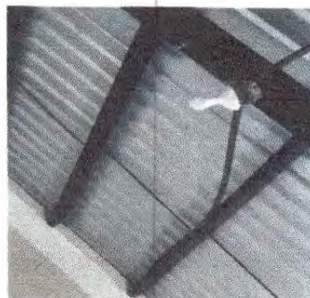
Foto 14: INSTALACIÓN DE UNIDADES DE LUZ (INCLUYE INTERRUPTOR, DUCTO Y CABLE ELÉCTRICO)
