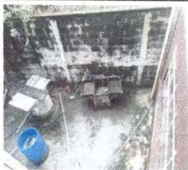
Foto 15: SUSTITUCIÓN DE PILA DE CEMENTO DE DOS LAVADEROS
