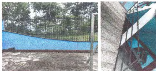
Foto 8: MANTENIMIENTO DE BARANDA DE METAL
